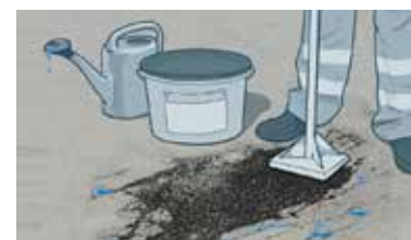
4. Arbeitsschritt: BEFEUCHTEN & VERDICHTEN (Befeuchten nur bei reaktiven Kaltmischgütern NOVAREP® KM-R und KM-P)
