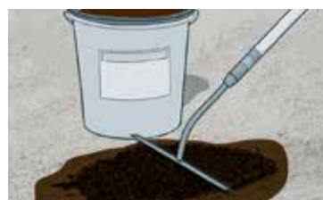
3. Arbeitsschritt: SPLITTSPITZEN SCHARF ABZIEHEN (mit dem Moosgummischieber in den Asphalt einarbeiten)
